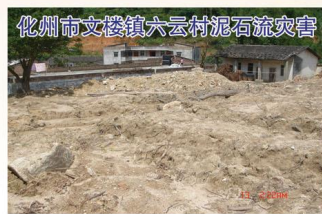
2006年7月16号，该泥石流造成38间民房和小学被冲毁。
